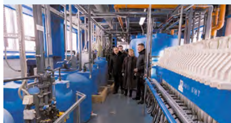
Губернатор Мурманской области на пуске очистных сооружений.
