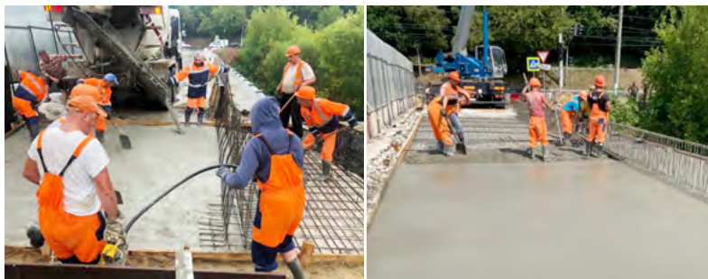
РЕМОНТ МОСТА ПО УЛ. МИРА (ПОВОРОТ К ДТЮ) В Г. ВЛАДИМИРЕ
