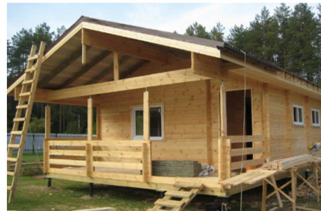
отделки, кроме покраски, не требуется. Полы сделаны из шпунтовой сухой доски толщиной 28 мм, а потолок – из евровагонки толщиной 12,5 мм.
